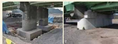
コンクリート巻き立てによる橋脚補強 1.施工前 2.施工後
