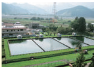
浄水場 (葵区門屋)
